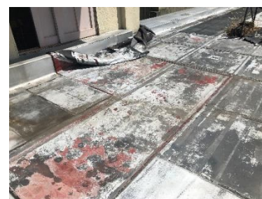
【小金井団地 3号館防水状況】
